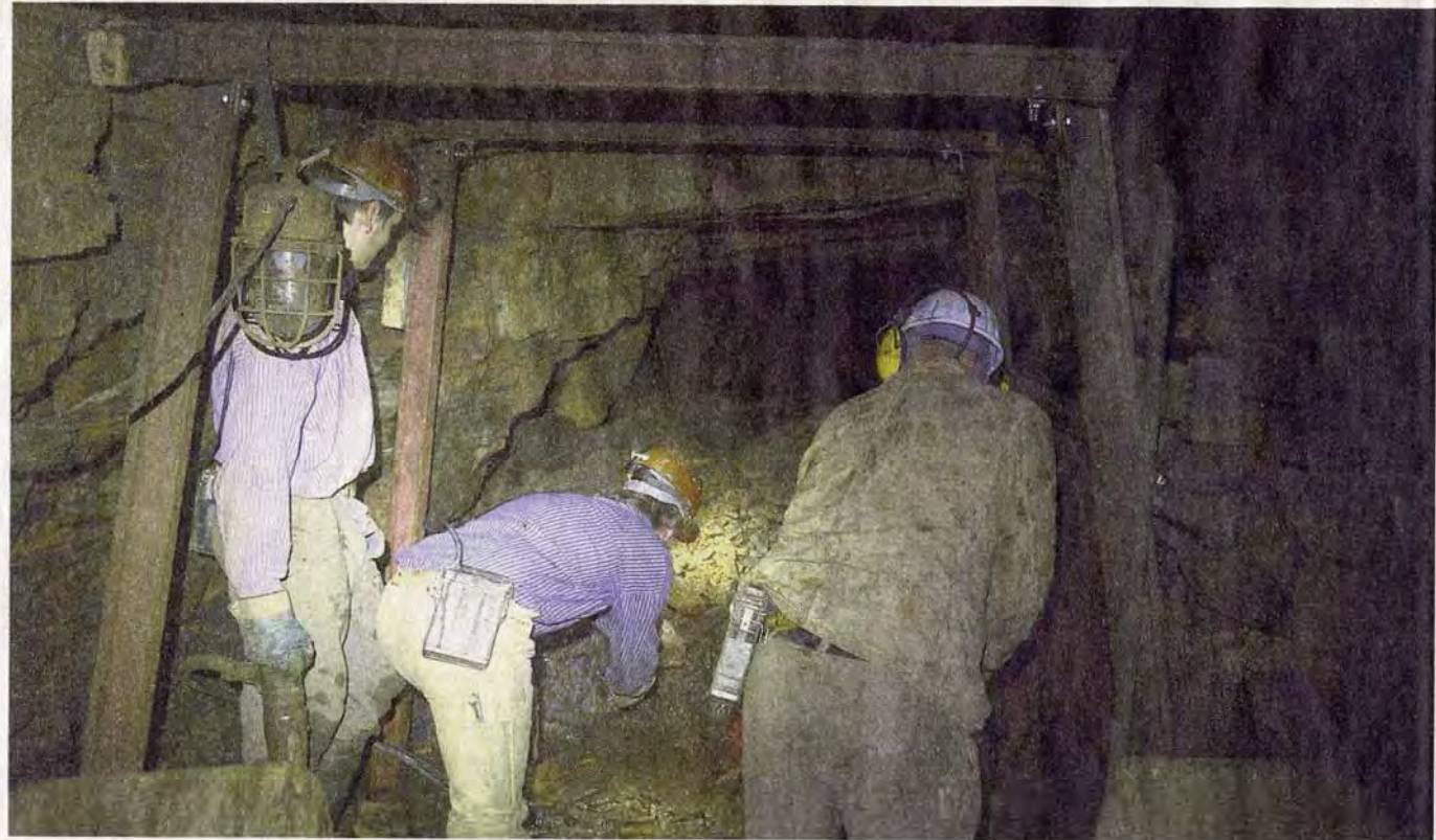
Immer weiter in den Berg: Die Arbeitsgruppe erschließt ein neues Kohleflöz.
