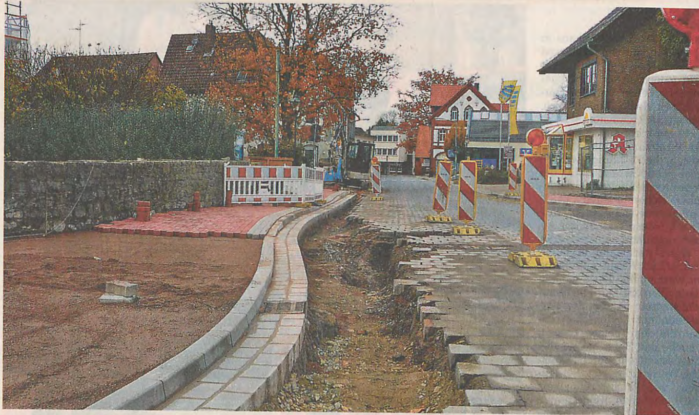
Die Arbeiten am Bürgersteig sind bereits weit fortgeschritten.
