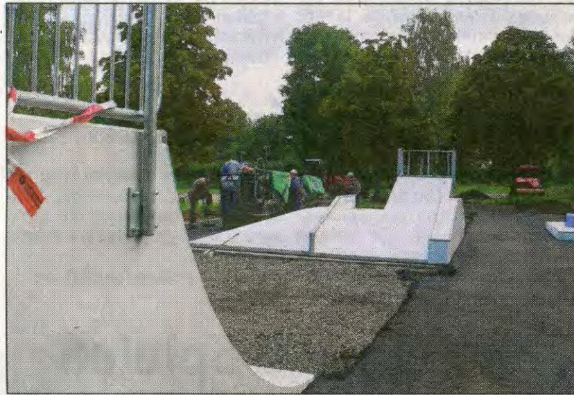
Kurz vor der Fertigstellung: die neue Skateranlage im Lauenauer Sportpark.
