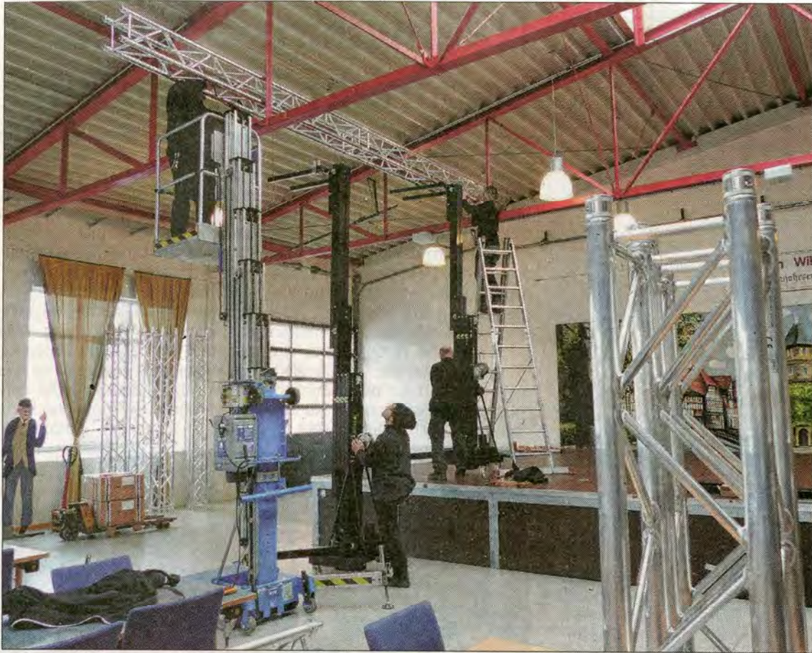
Montage in luftiger Höhe: Die Sägewerk-Bühne hat Alu-Traversen erhalten.
