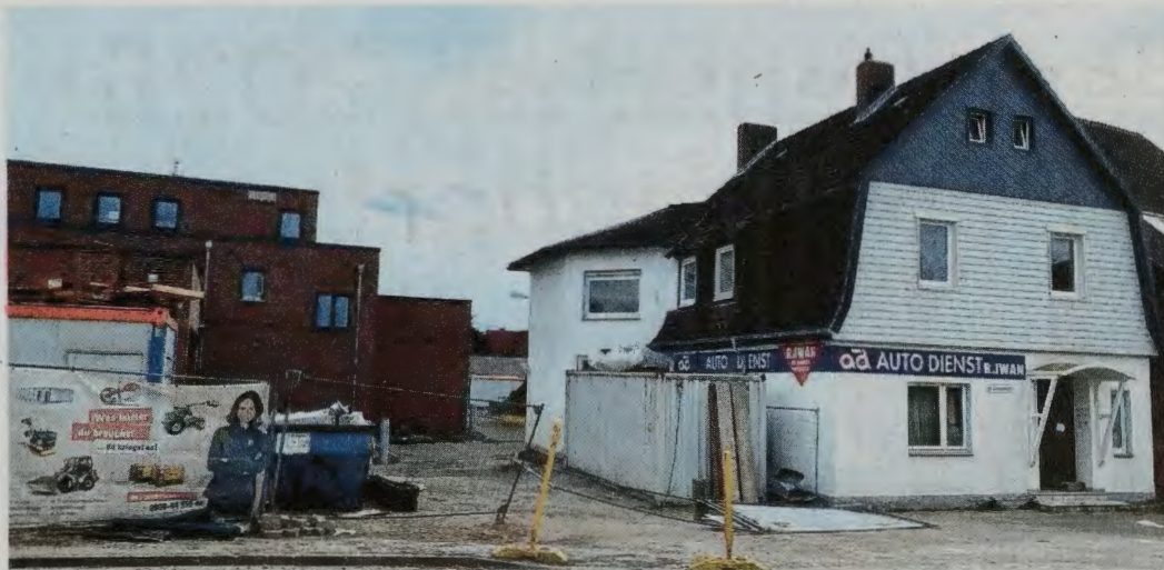
Wohn- und Werkstatthaus von Marlis und Erhard Meyer vor dem Abriss...
