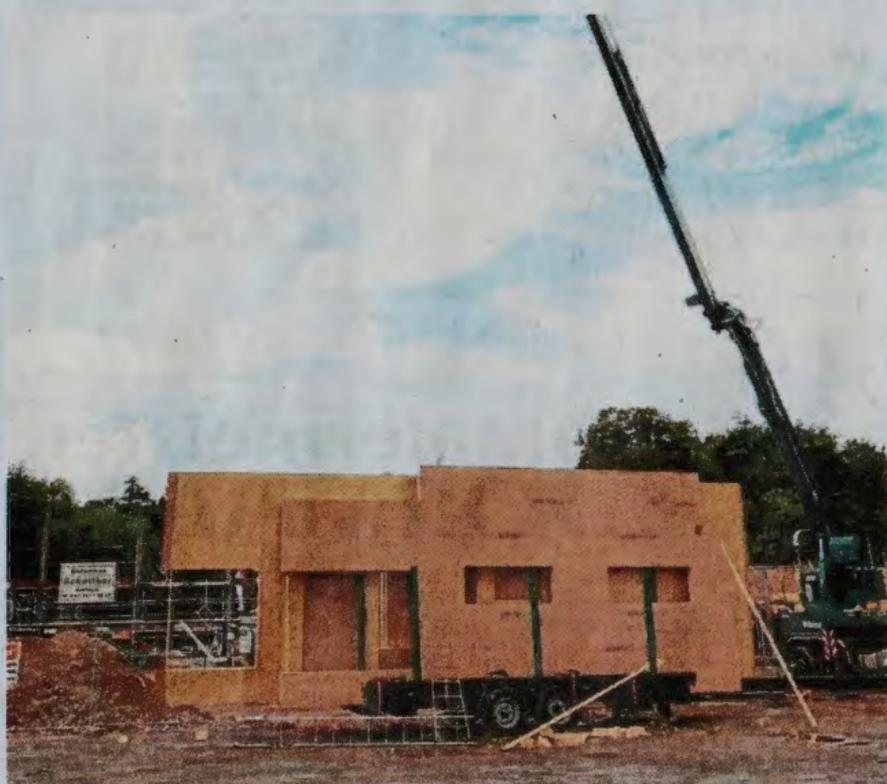
Fertigbauteile in Holzrahmenbauweise lässt den Bauvorgang zügig voranschreiten.
